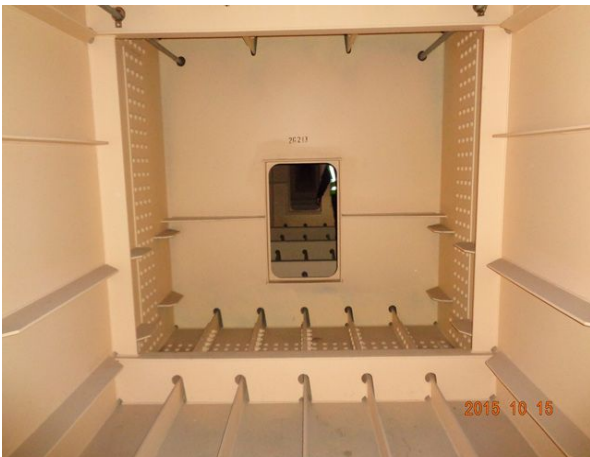
거더 내부 전경
